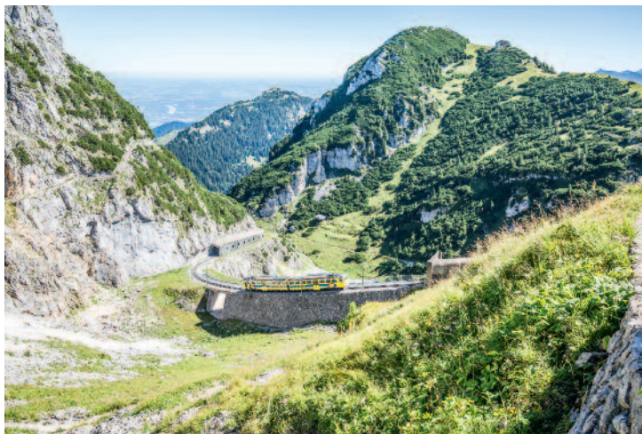
Zahnradbahn | Talstation (Brannenburg): 508 m | Bergstation: 1.723 m
